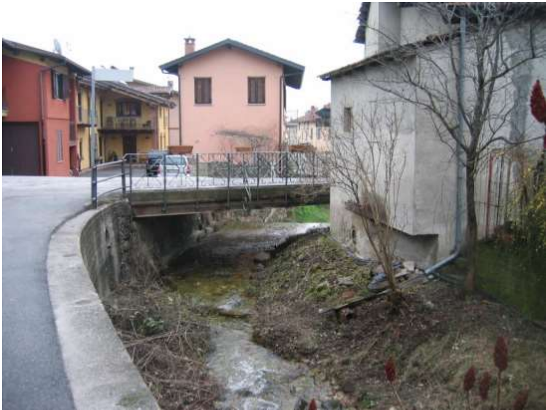
F.07 - Rio Faussimagna: ponte di Via Gioera (lato monte).
