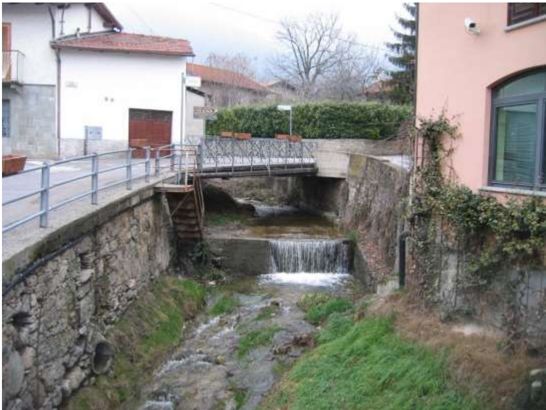
F.08 - Rio Faussimagna: ponte di Via Gioera (lato valle).
