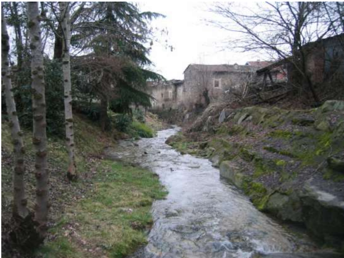
F.04 - Rio Faussimagna: all'ingresso dell'abitato di Villar San Costanzo (verso valle).
